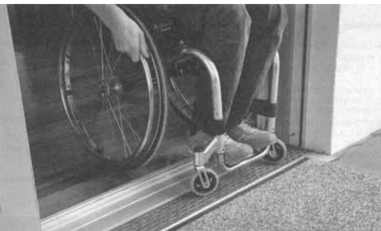
Seuil accessible et caniveau d'évacuation des eaux pluviales du balcon. Extrait de l'ouvrage "Handicap et construction" de Louis Pierre GROSOIS aux Editions LE MONITEUR. Avec l'autorisation de l'auteur.
